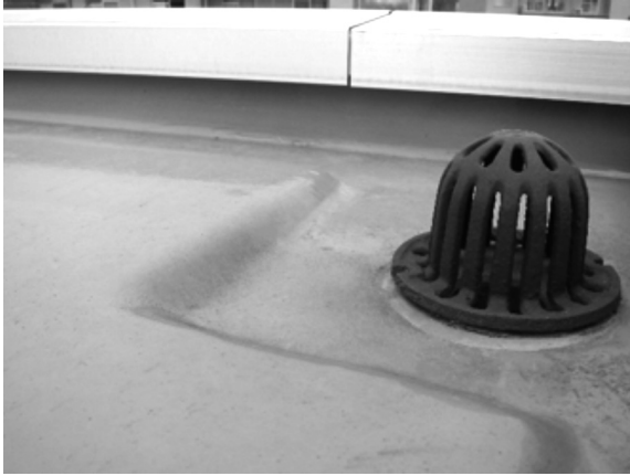
写真1 十分な膜厚が確保されている出隅入隅部
